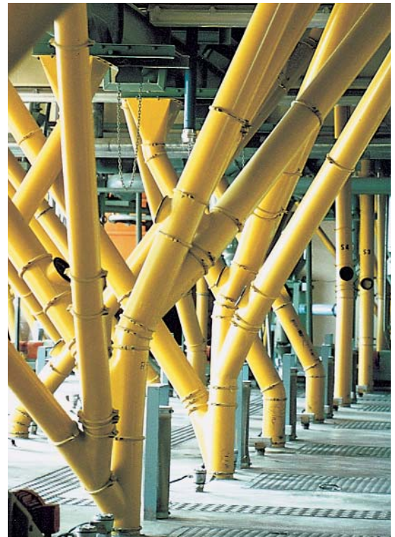
▲ Rohr- und Verteilsysteme nach dem Baukastensystem für Schüttgüter-Handling sowie für lufttechnische Anlagen in druckstoßfester Ausführung bis 3 bar Überdruck, Normal- und Edelstahlausführung
